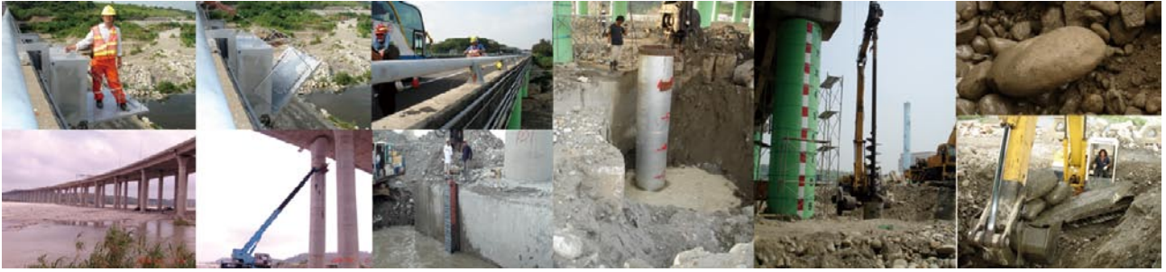
圖2 大甲溪國道一號及三號高速公路橋墩基礎監測系統安裝。
