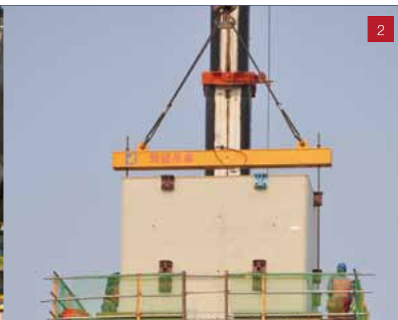
2 「後拉式預鑄節塊橋柱」工法已應用於台中四號生活圈之橋梁工程
