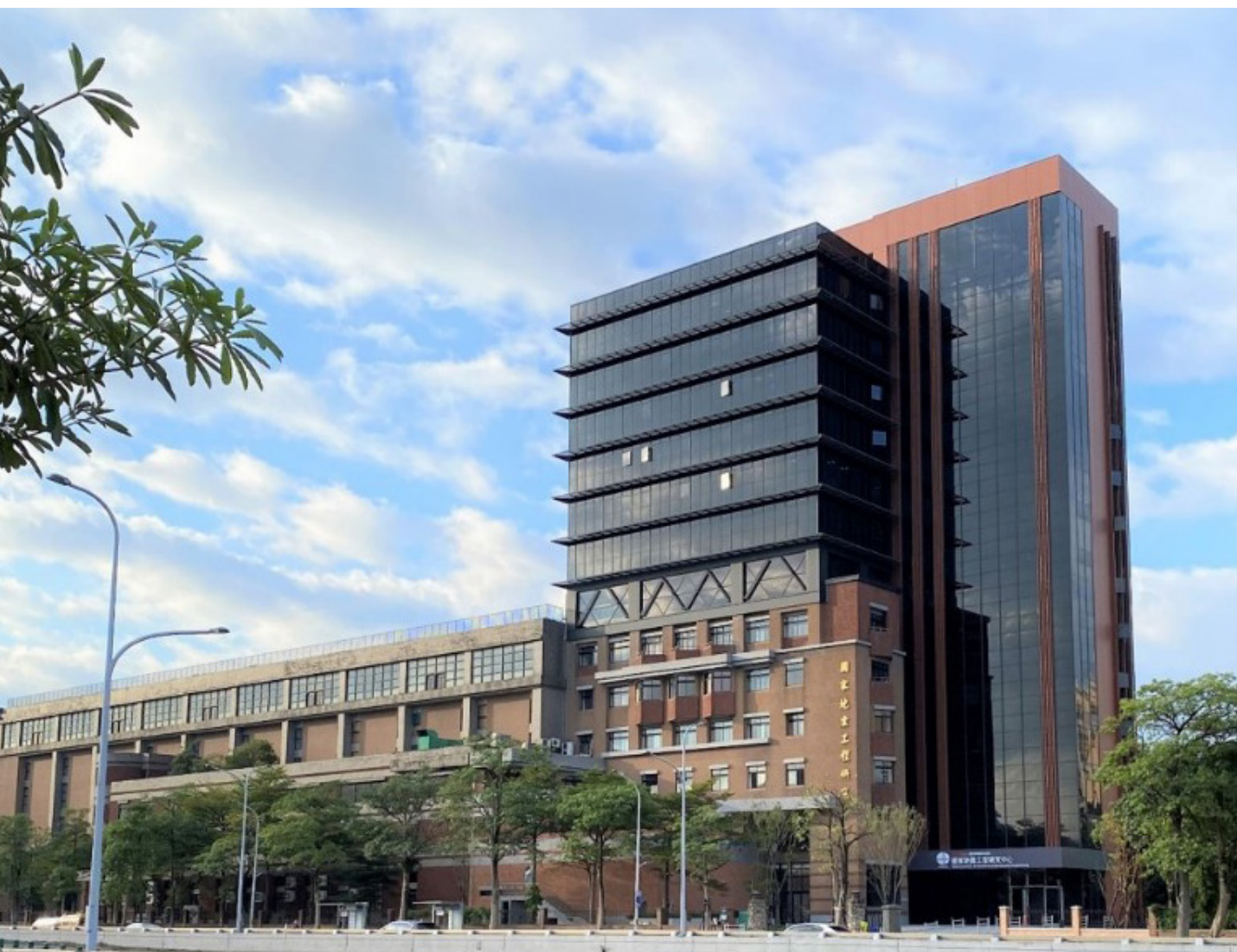
▲ 增建後的國震中心大樓外觀 The extended NCREE building
